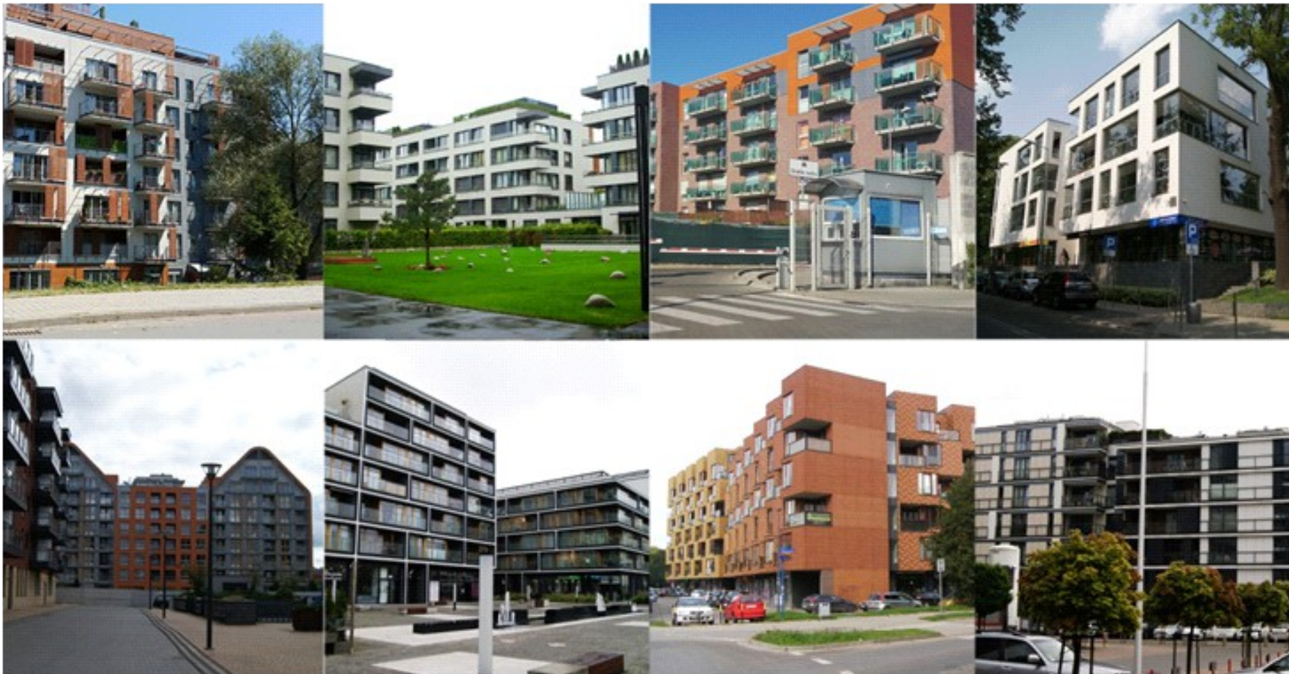
Omawiane przypadki zespołów zabudowy (os. Atal Francuska, Katowice; Osiedle Ażurowych Okiennic, Warszawa; os. Dębowe Tarasy, Katowice; os. Apartamenty Novum, Kraków; os. Aura Gdańsk, Gdańsk; os. 19ta Dzielnica, Warszawa; os. Corte Verona, Wrocław; os. Mozaika Mokotów, Warszawa) / Case studies of housing estates (fot.: T. Bradecki, J. Swoboda, K. Nowak)
