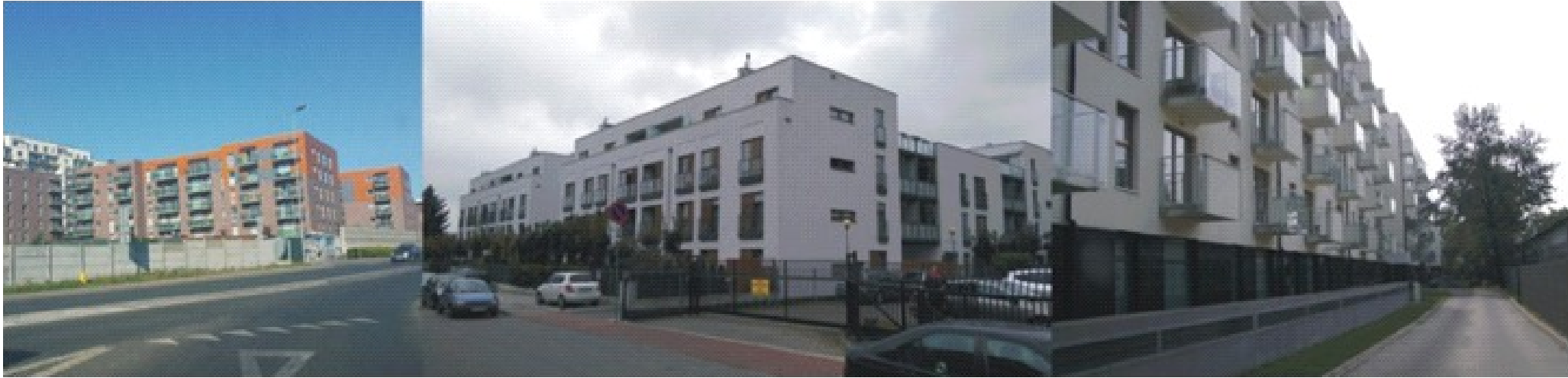
Przykłady przestrzeni na styku nowych osiedli z sąsiedztwem od lewej: os. Dębowe Tarasy, Katowice, os. Quadro House, Poznań, os. Apartamenty Wiśniowa, Wrocław II.1 Examples of the spaces on the edge of new estates and the neighbourhood; from left: Dębowe Tarasy, Katowice, Quadro House estate, Poznań, Wiśniowa apartments, Wrocław T. Bradecki, P. Gembalczyk K.Fonfara)
