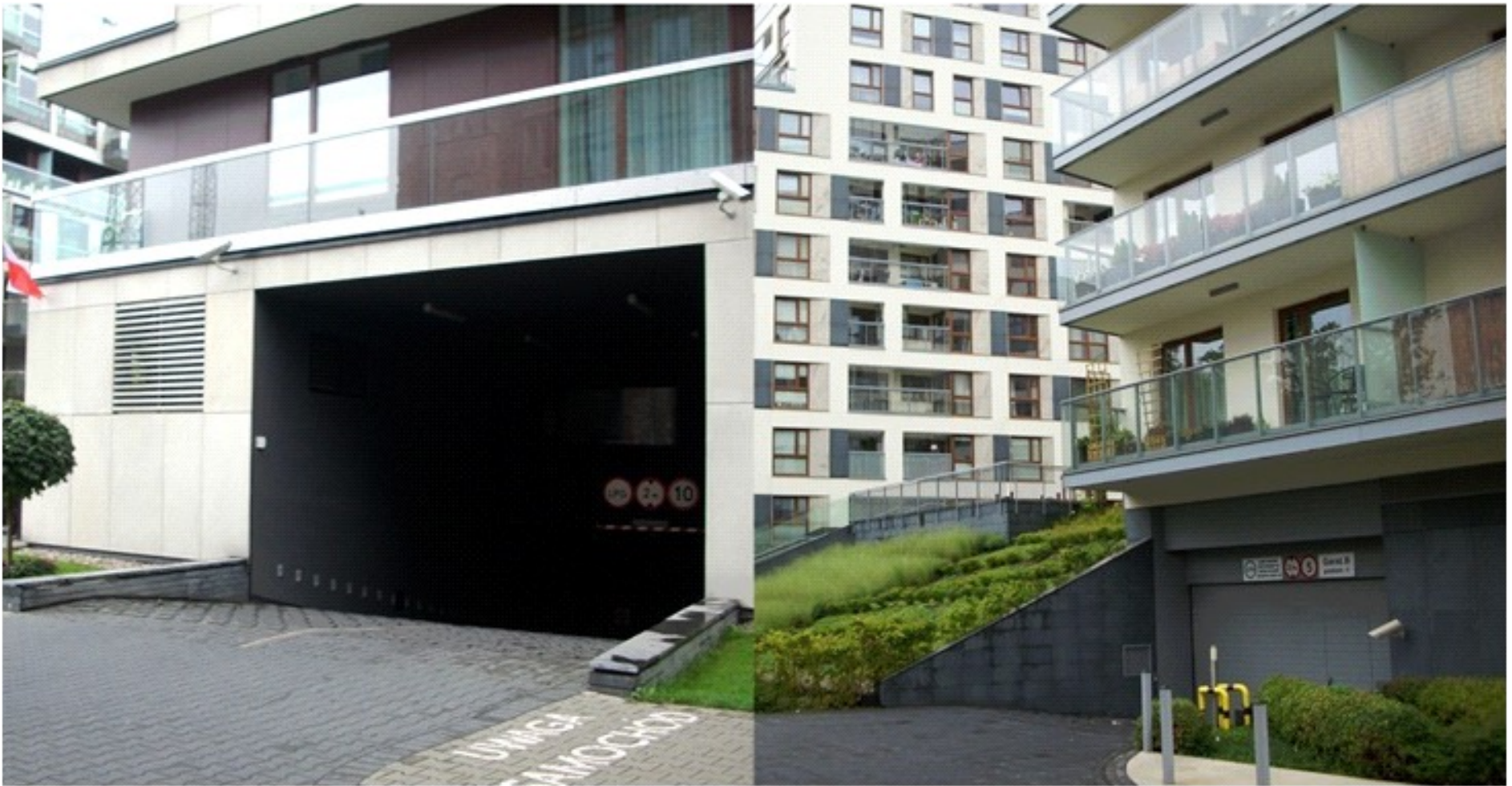
Wjazdy do parkingów podziemnych (os. Menolly Nowe Powiśle, Warszawa; os. Cynamonowy Dom, Warszawa) / Entrances to the underground parking floors (fot.: K. Nowak)
